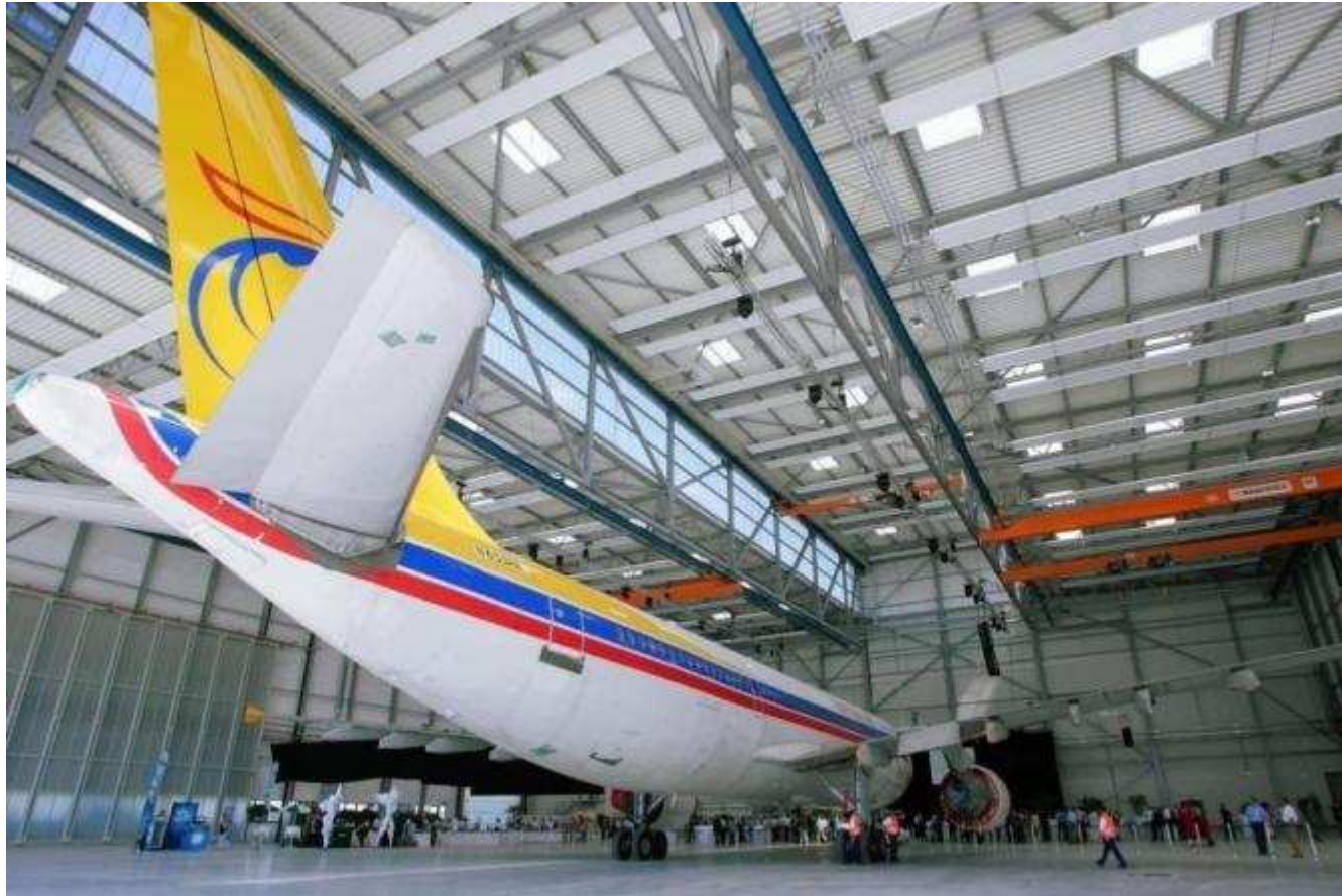
Paneles de techo radiante de máximo rendimiento
