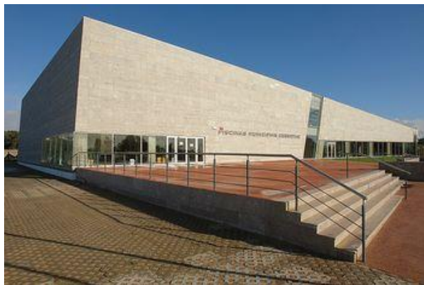
Piscina con caldera de biomasa para agua caliente
